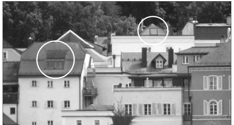
Leider schmälern die „Dachsünden“ die Freude über ansonsten gelungen sanierte Baudenkmäler
