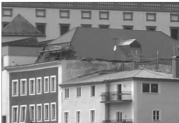
Sieht aus wie eine Geschwulst, die aus dem Haus ausbricht – von der Innstadt her ist der Anblick sogar noch hässlicher
