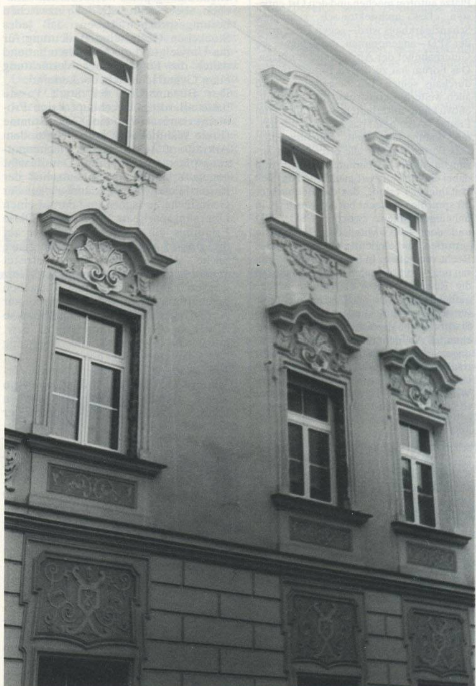
Kirchplatz: Plastikfenster in Passaus schönster Fassade – ein Dauerzustand?
