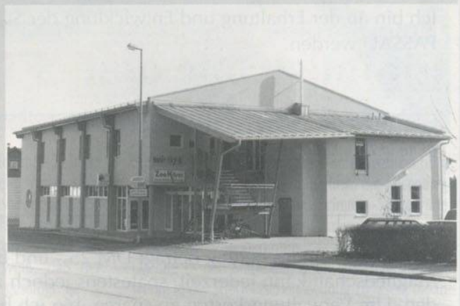
Neuburger Straße 123: Neubau eines Geschäftshauses, bei dem der Architekt bewußt eine zeitgemäße Formsprache versucht hat, was aber bei diesem Gebäude an einer Geschäftsstraße gründlich danebengegangen ist. Sowohl die Proportionen als auch die Details stimmen einfach nicht. Im Grunde ist es ein langweiliger Kasten mit wie angeklebt wirkendem asymmetrischen Vordach.
