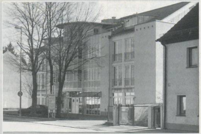
Neuburger Straße 121: Ein Geschäfts- und Bürohaus, das in seinen Proportionen zur Straße immerhin einen städtischen Charakter zeigt, das aber in den Fassadendetails und mit dem Tonnenelement über dem Eingang etwas billig erscheint – zumindest aber ein Versuch zeitgenössischer Architektur.
