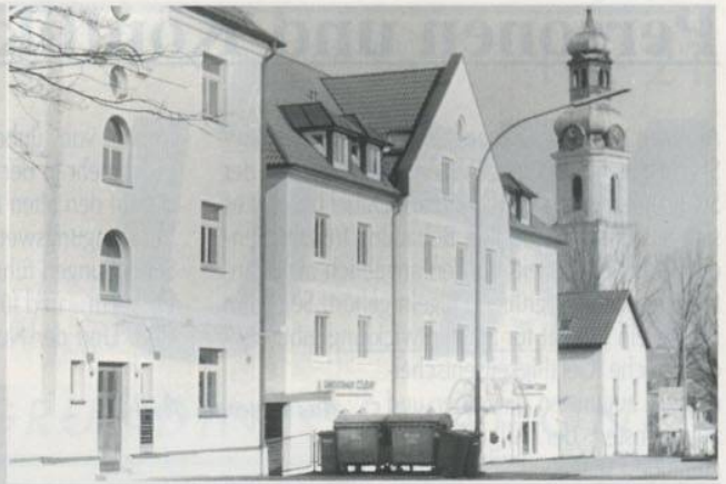
Neuburger Straße 74: Ein Geschäftshaus, das in seiner Gesamtform die angrenzenden Stadthäuser imitiert, jedoch eine sehr eintönige Fassade erhielt, die von einem viel zu gewaltigen Giebel bekrönt wird. Die Details der Schaufensteröffnungen wirken überaus gequält.
