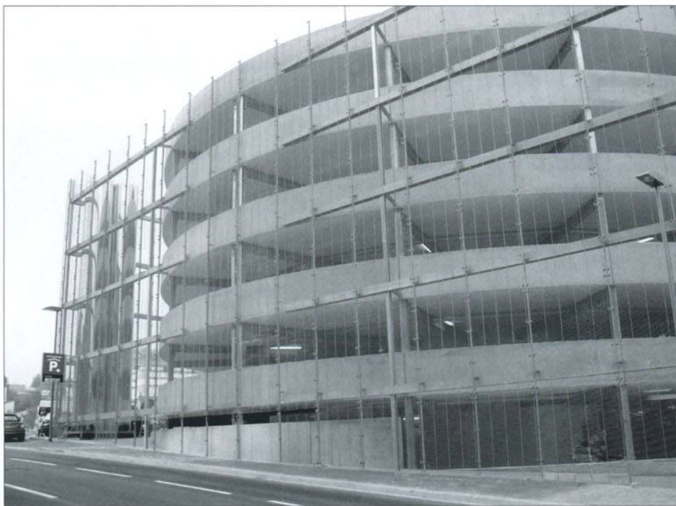
Kein Bauzaun, sondern angeblich schon fertig: Die neue Zentralgarage.
