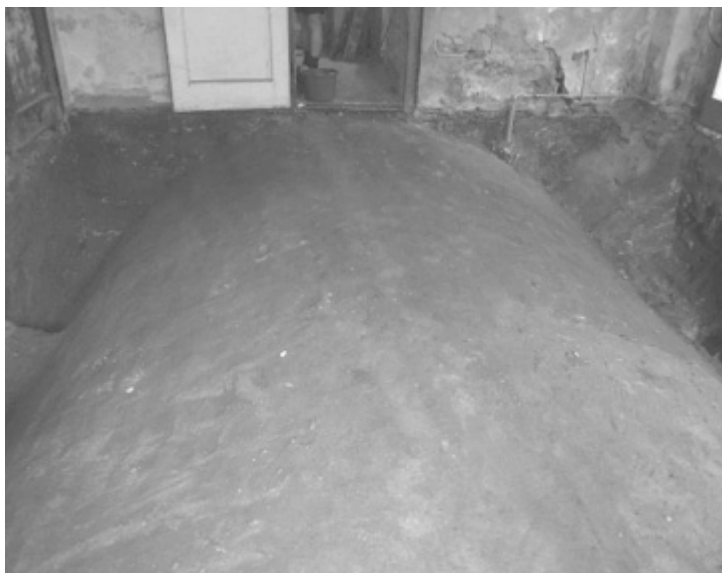
Perfekte Gewölbe der 2. Hälfte des 16. Jh., vom Schutt entlastet.
