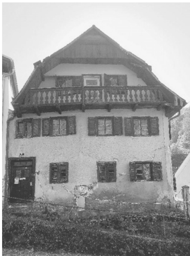
Linzerstraße 2 vorher und nach dem Abbruch
